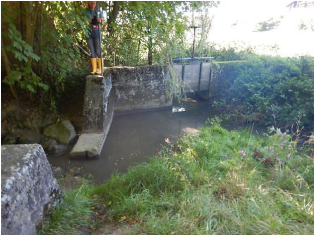
Abbildung 1.2: Wehr mit Ausleitungsbauwerk nördlich der Steeger Siedlung (aquasoli 2023a)
