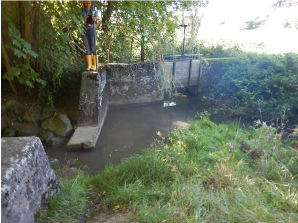
Abbildung 1.2: Wehr mit Ausleitungsbauwerk nördlich der Steeger Siedlung (aquasoli 2023b)
