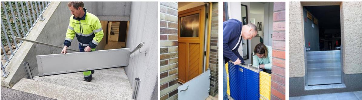
Absicherung durch bauliche Erhöhung u. Dammbalken
