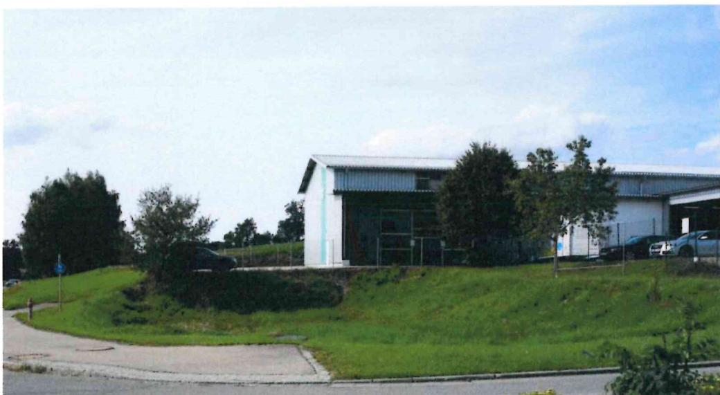
Einfahrtsbereich mit Regenrückhaltebecken
