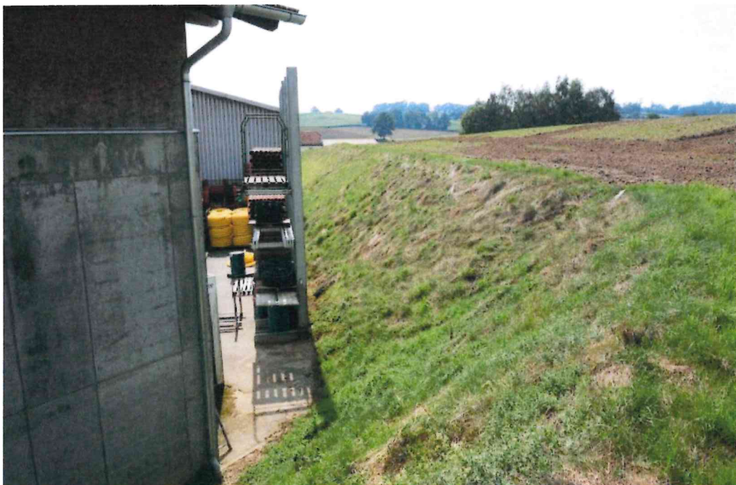
Ostseite des bestehenden Zentrallagers, hier sollen die neue Hallen in die Böschung hinein geschoben werden.
